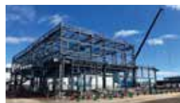
※建設中の新センター
